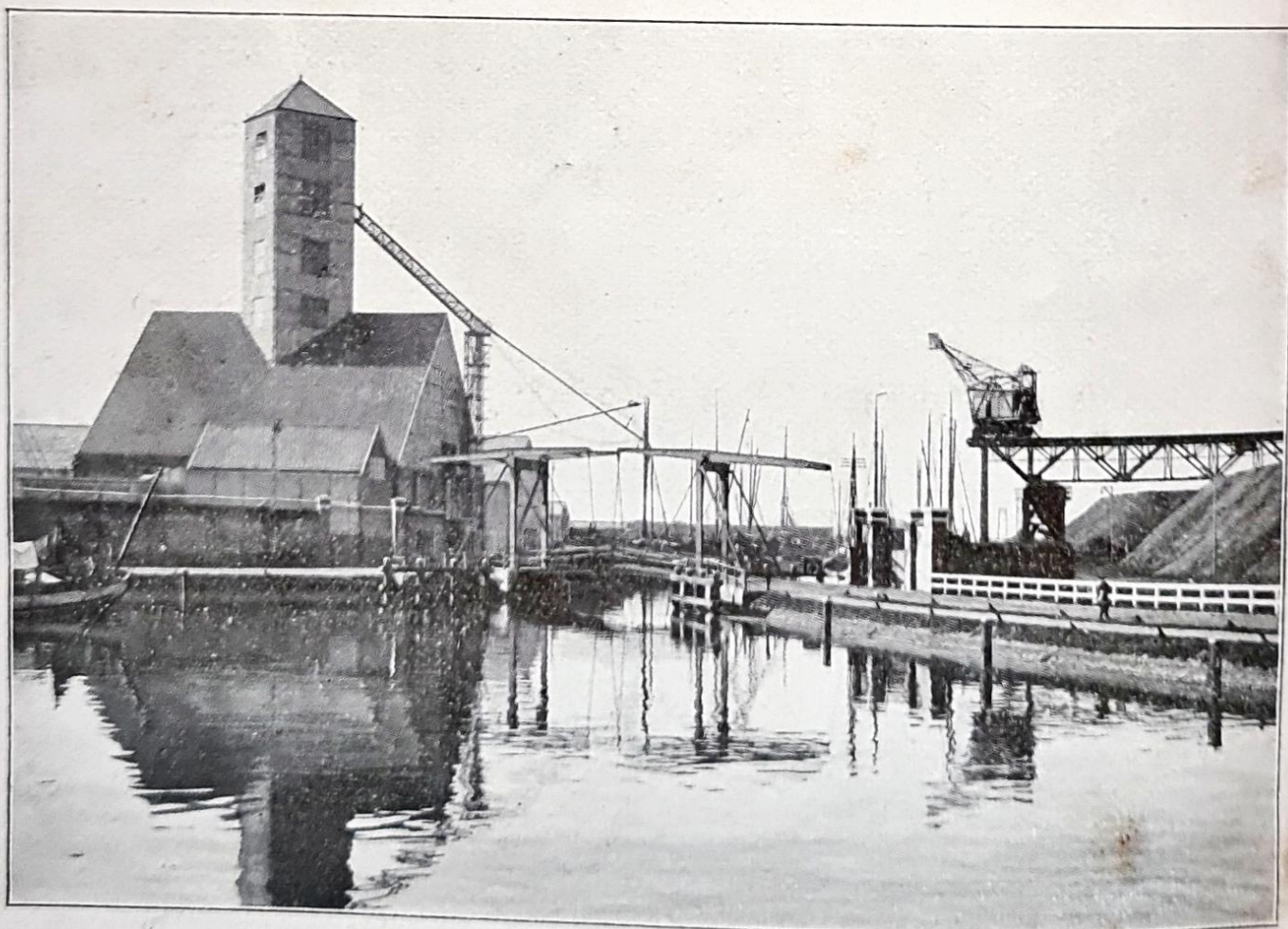
De elevator, die de grondnoten uit de schepen in de fabriekshaven opzuigt.
