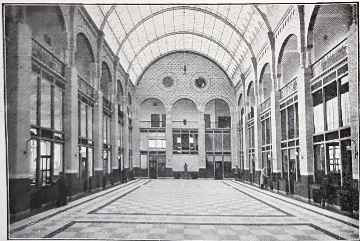
De groote hal in het kantoorgebouw.
